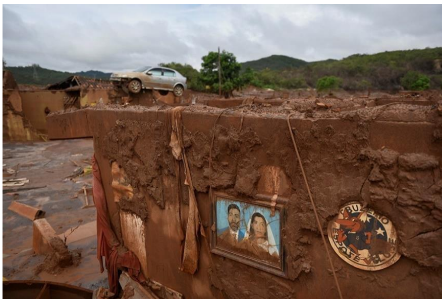
Foto 6. Tragédia provocada pelo rompimento da barragem de minério de ferro da Samarco, Fundão em Mariana
